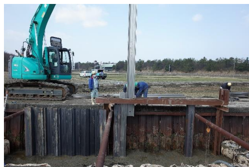
写真-2 ステンレス鋼矢板の打設
